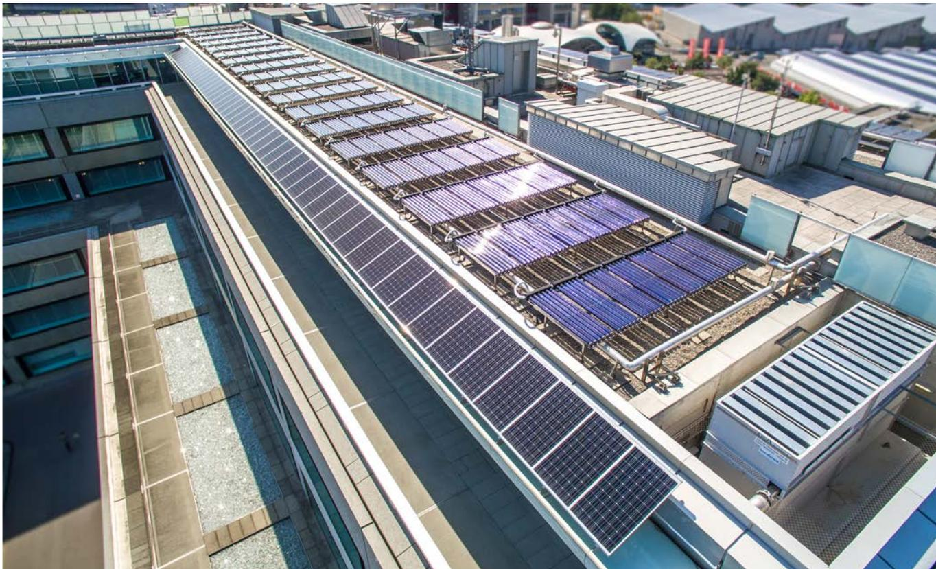
Die solarthermischen und photovoltaischen Anlagen auf dem Dach von Pictets Hauptsitz in Genf
